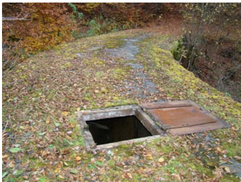
Fig. 5. Gură de vizitare a galeriei
