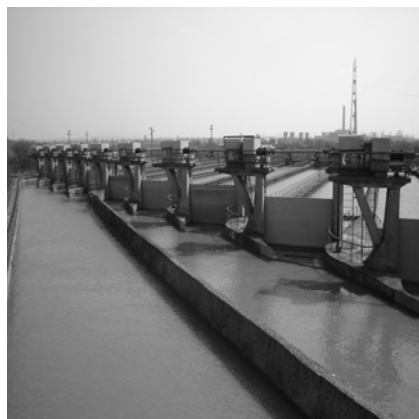
Foto 2. Bazinul de deznisipare baraj Ișalnița
