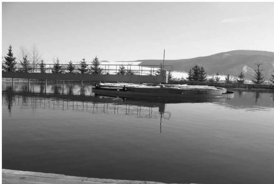
Fig. 1. Stația de tratare a apei de la Petrești
