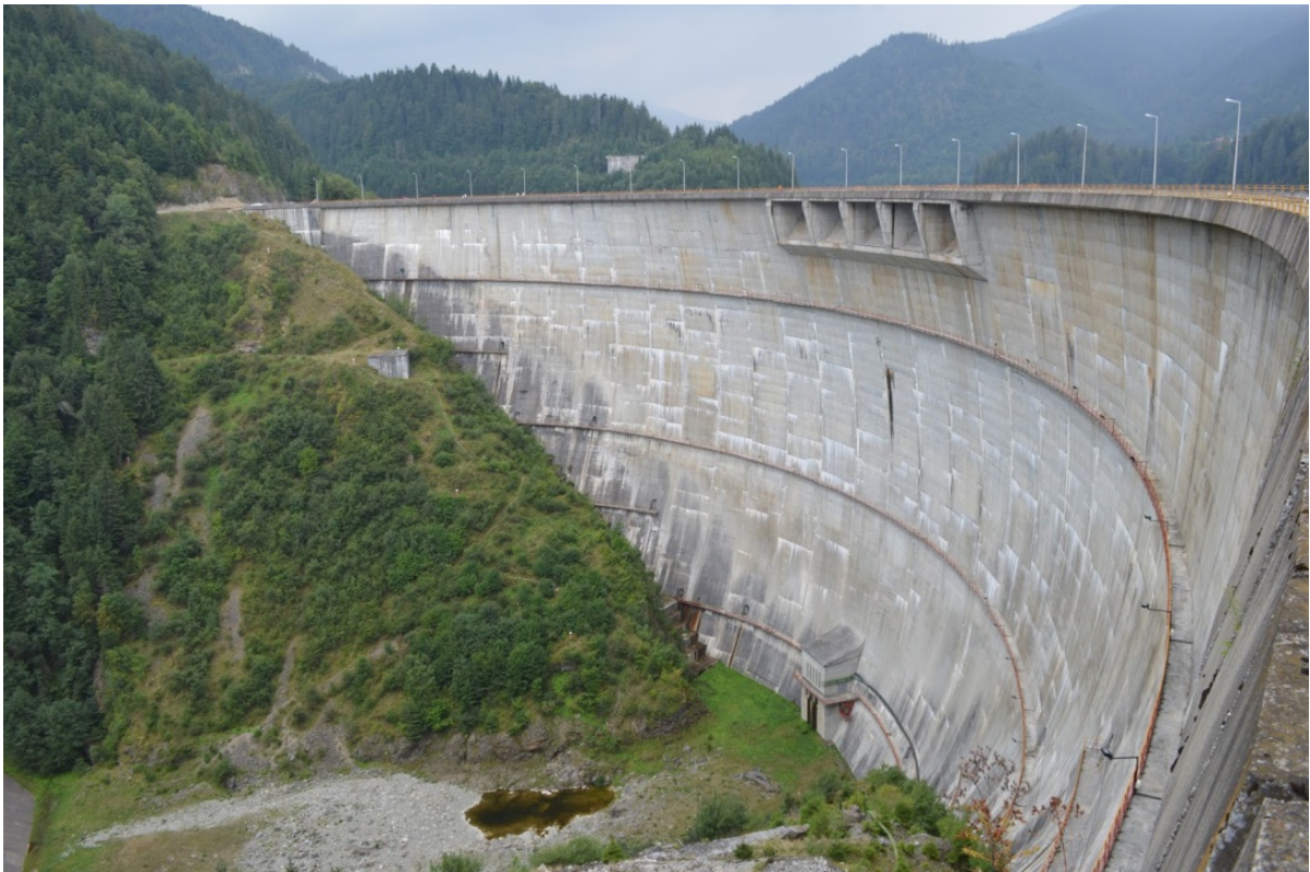
Fig. 2. Barajul Drăgan (arc cu dublă curbură)
